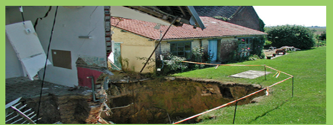
Effondrement d'une cavité souterraine en zone urbanisée (Photographie BRGM)
