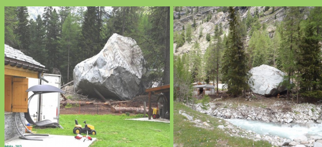
Chute d'un bloc de 500 m 3 à Bramans à proximité d'un chalet - La dimension du bloc est impressionnante au regard de celle du chalet (Juin 2013 - Sources : RTM 73 et DDT 73)
